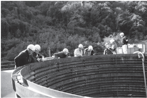
(主要地方道道路改良工事(2工区))
