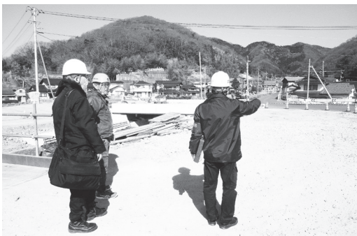
(河川浸水対策工事)
