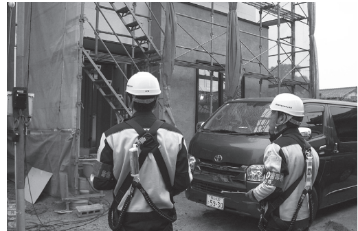
(低層住宅新築工事)
