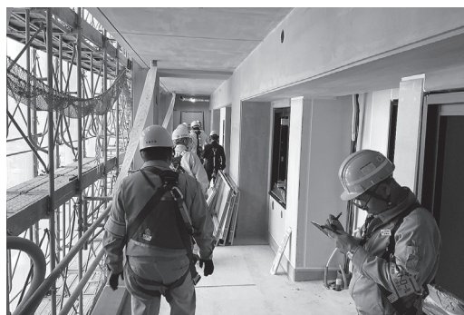
(南区のマンション新築工事)
