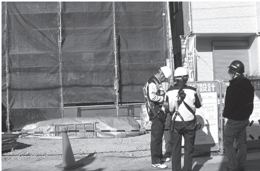
(低層住宅新築工事)
