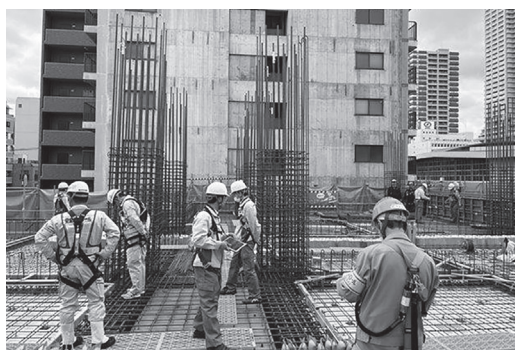
(中区のビル建替工事)
