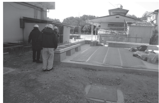
(消防団格納庫工事)
