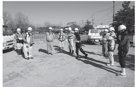
(多目的広場整備工事)
