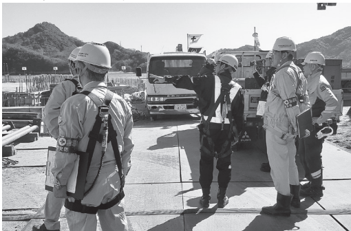
(会社社屋新築工事)
