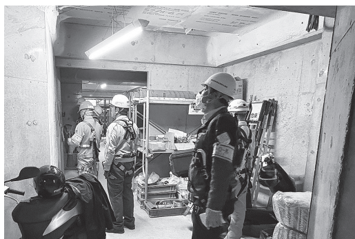
(東区のマンション新築工事)
