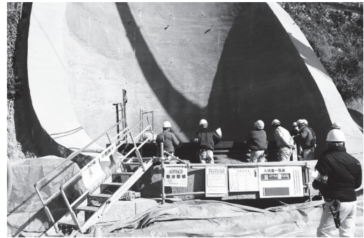
(主要地方道道路改良工事(3工区))
