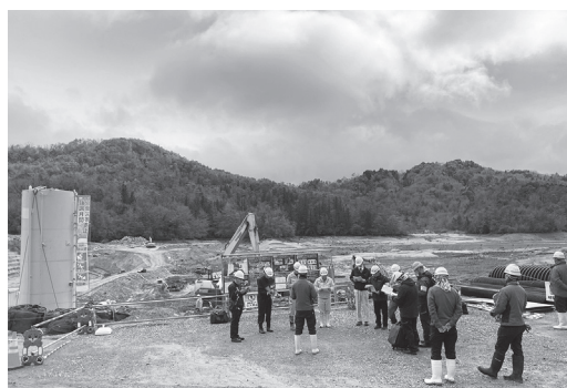
(東広島県の県営ため池整備事業工事)
