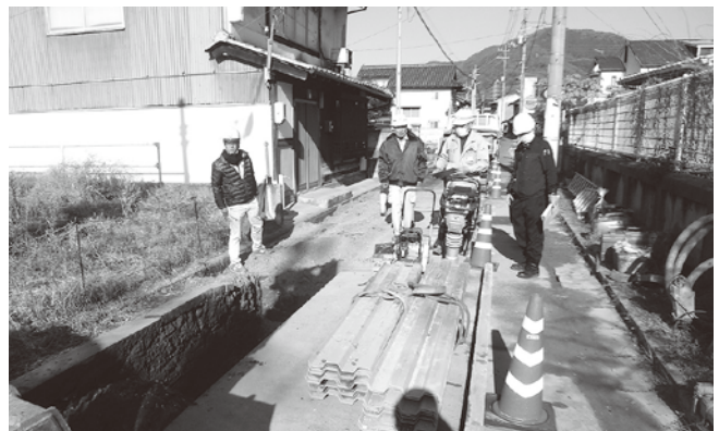
市街地下水道工事
