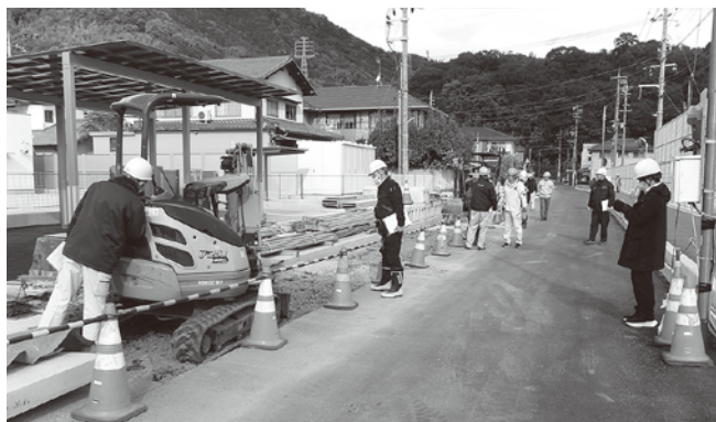
県道道路改良工事
