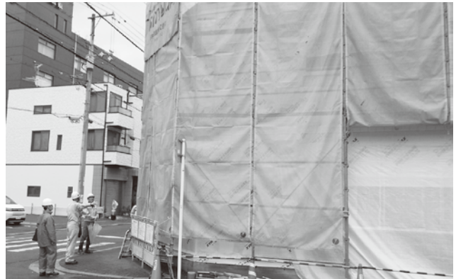
低層住宅新築工事
