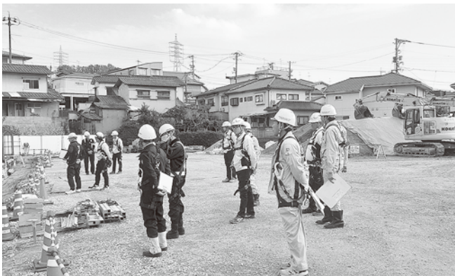
マンション新築工事
