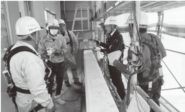
マンション新築工事
