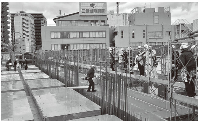
総合病院新棟建設工事
