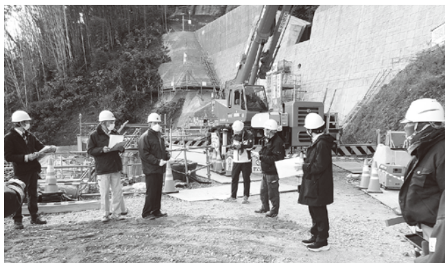
砂防堰堤工事
