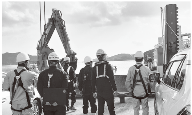
港湾改修工事
