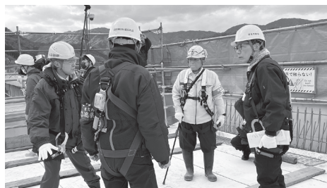
(橋脚頂部でのパトロール風景)
