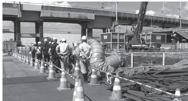
（ポンプ場建設工事）
