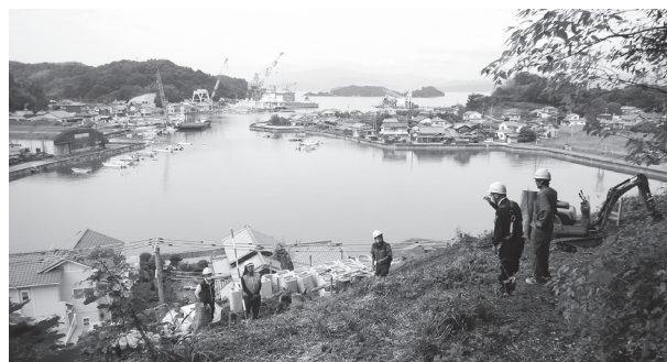
（町道道路災害防除工事）
