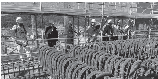
（高速道路下部工工事）
