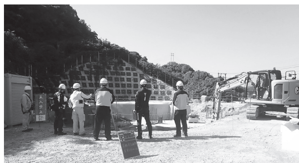
（配水池築造工事）
