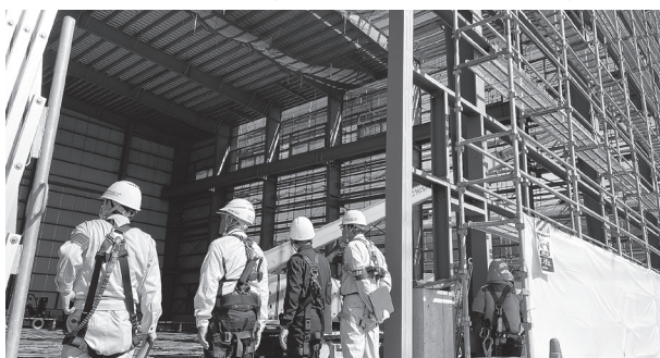
（会社倉庫新築工事）
