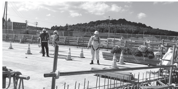
（一般国道道路改良工事）
