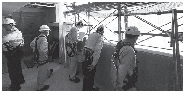
（マンション新築工事）
