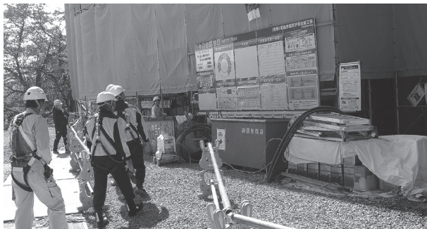
（男子学生寮改築工事）
