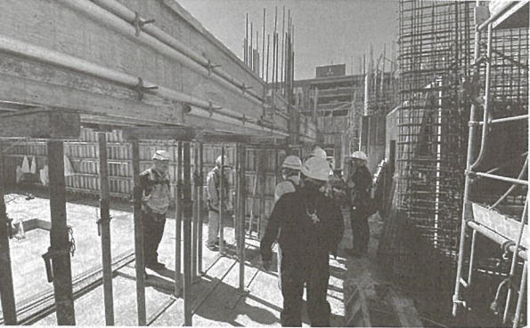
(マンション新築工事 1)
