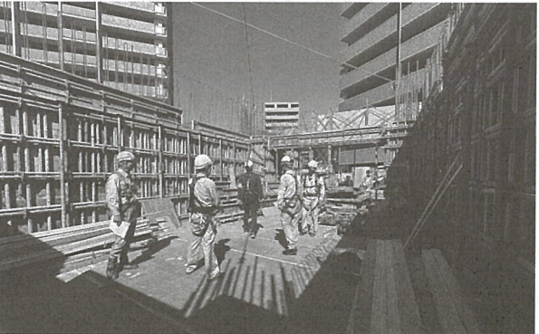
(マンション新築工事 2)
