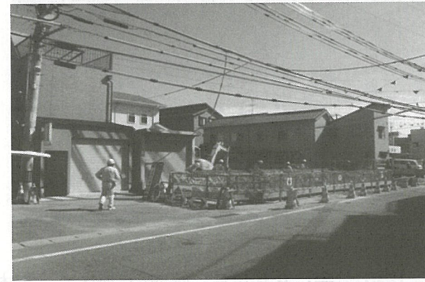
(道路改良工事)
