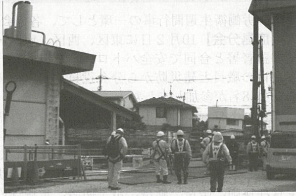
(ポンプ場築造工事)
