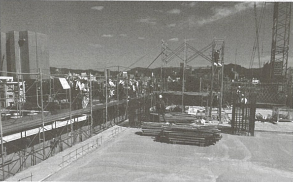
(水資源再生センター管理棟新築工事)
