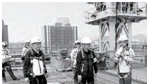
12階(屋上)の状況
