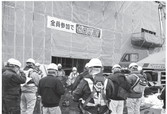
(小学校改築工事)
