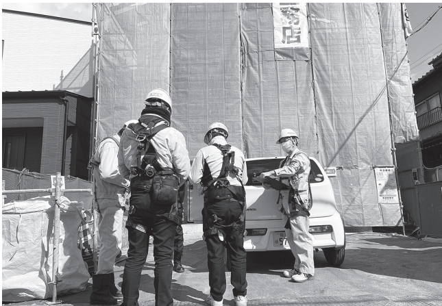
(低層住宅新築工事)
