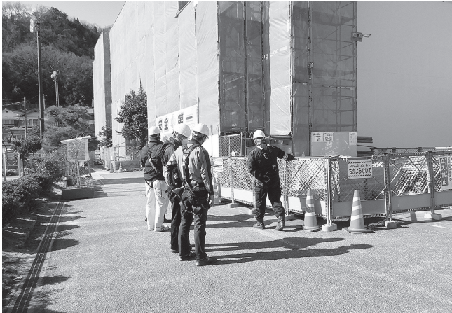
(小学校改修工事)
