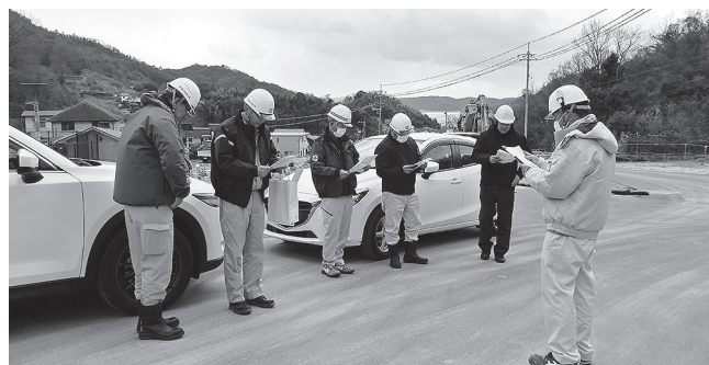
(溪流保全工外工事)
