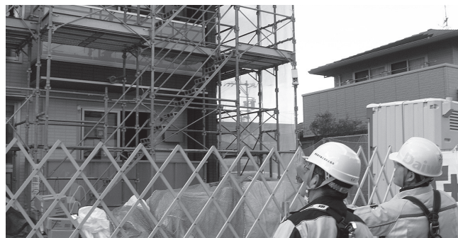
(木造住宅工事)
