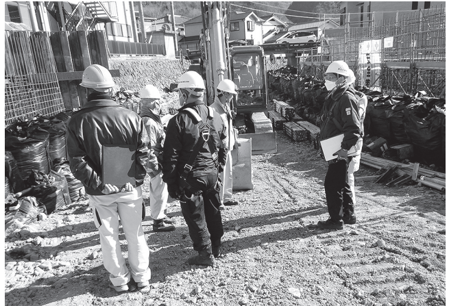
(道路改良工事)
