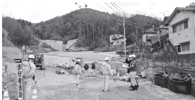
(溪流保全工外工事)
