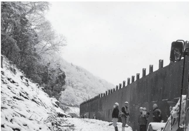
(道路改良工事)
