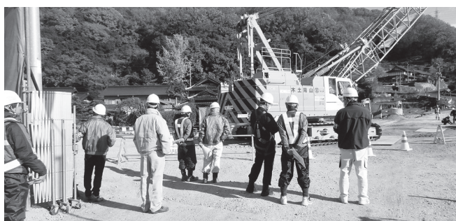
県道道路改良工事
