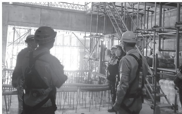
マンション新築工事(西区)
