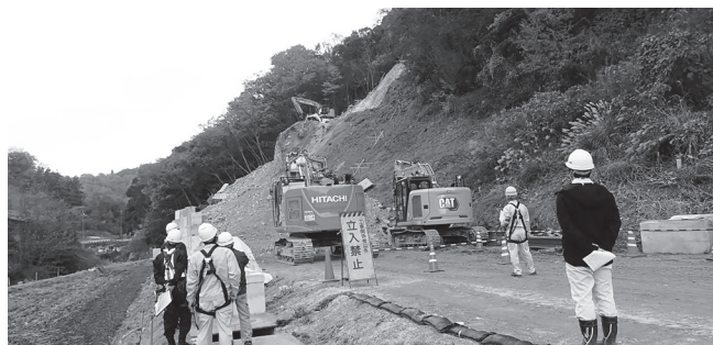
道路改良工事
