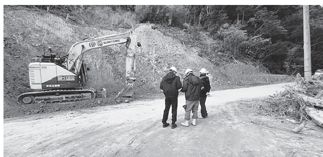
市道道路改良工事
