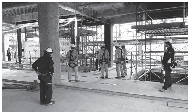
オフィスビル新築工事(南区)
