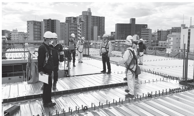
オフィスビル新築工事(東区)
