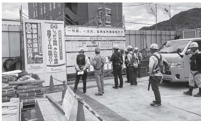
マンション新築工事(安芸郡)
