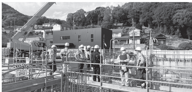
図書館建設工事
