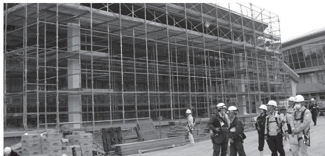
屋内プール増設工事
