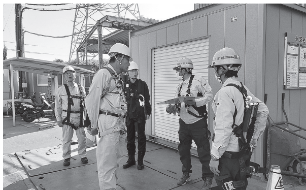
(焼却炉の建屋新築工事)
