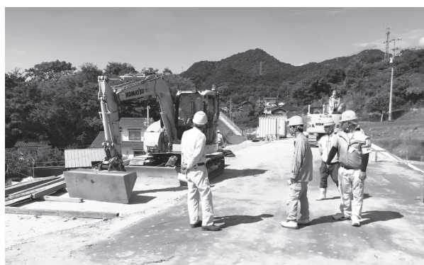
(竹原地区の道路新設工事)
