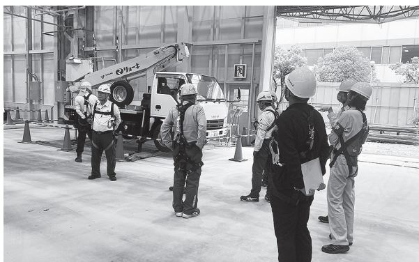
（南区の工場建設工事）
