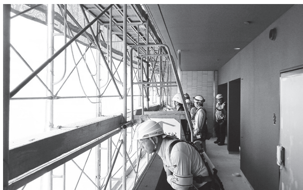
（西区のマンション新築工事）
