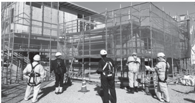
グループホーム棟建設工事
