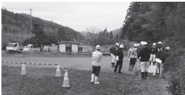
本村川災害復旧工事
