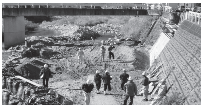
県道本多田佐伯線災害復旧工事
