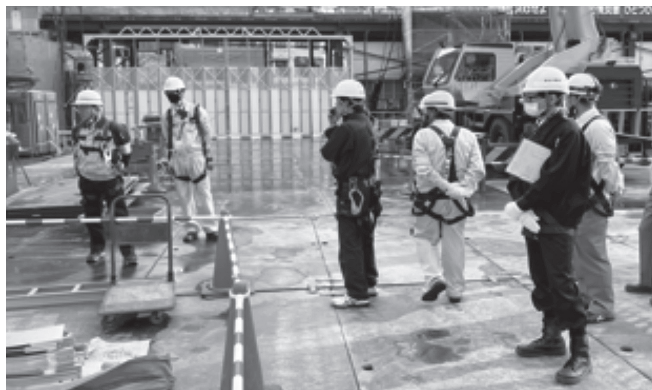
オフィスビル新築工事（中区）
