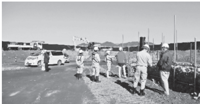
下黒島最終処分場工事
