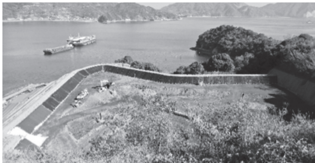
下黒島最終処分場工事
