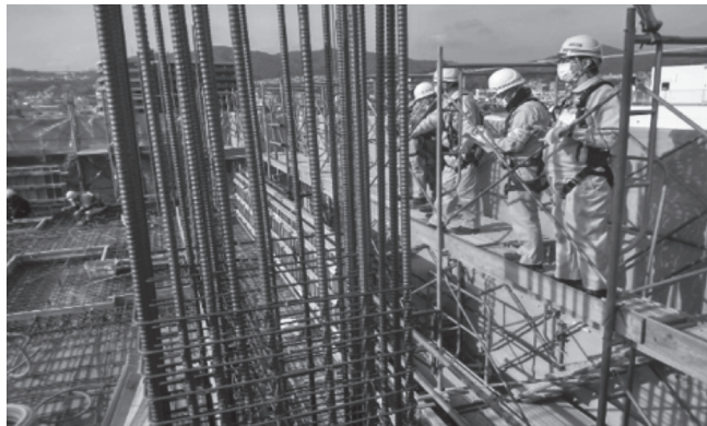
マンション新築工事（西区）
