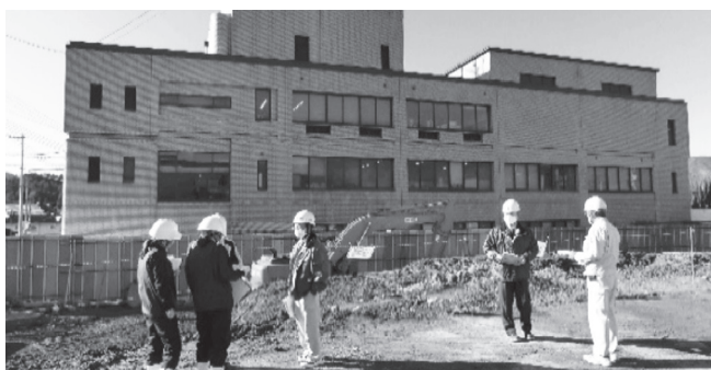
佐伯消防署整備工事
