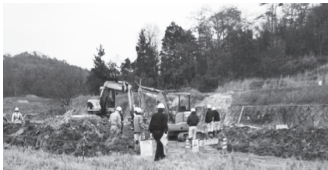
中野農地災害復旧工事
