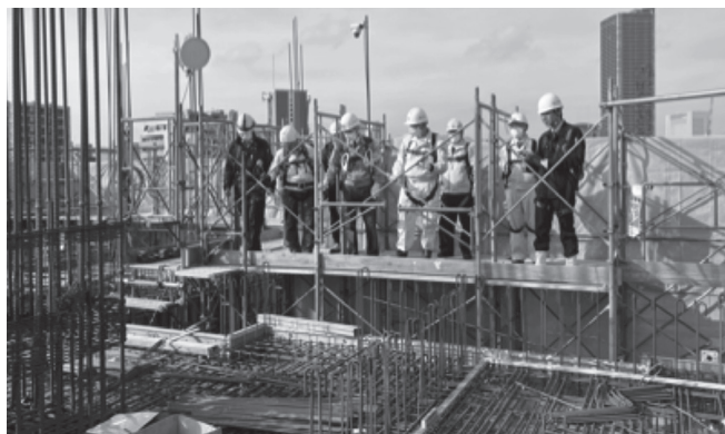
マンション新築工事（南区）
