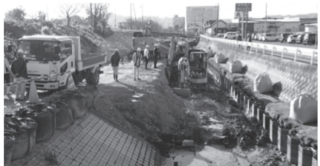
雨水幹線築造工事
