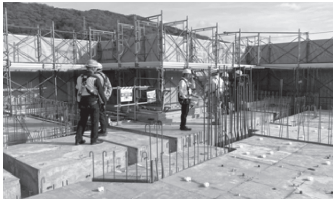
マンション新築工事（東区）
