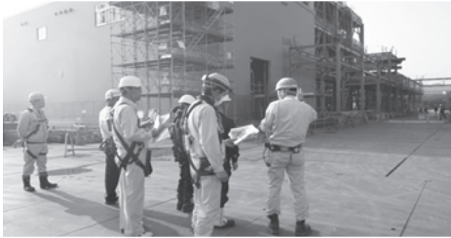
発電所建設工事
