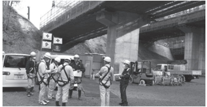
道路改良工事
