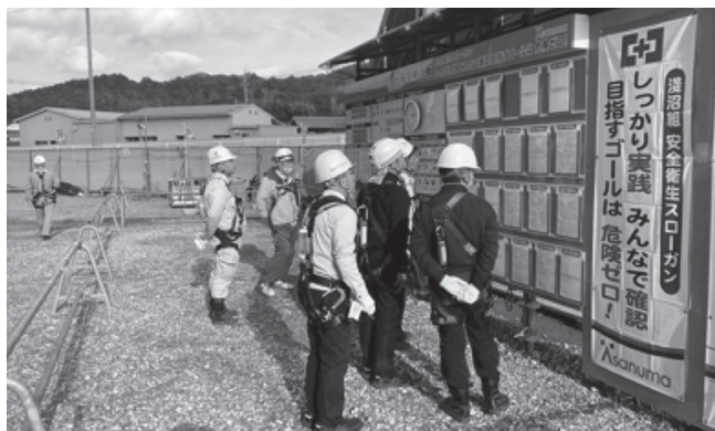
マンション新築工事（東広島市）
