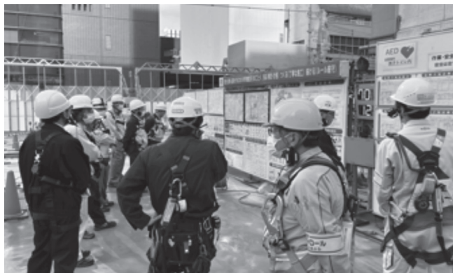
オフィスビル新築工事（中区）
