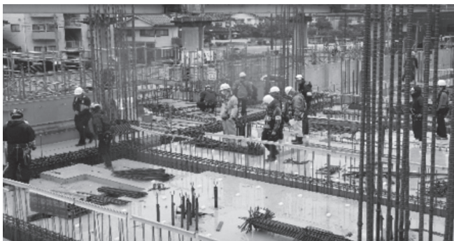
市営新宮沖住宅建設工事
