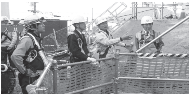
(現場のパトロール状況)
