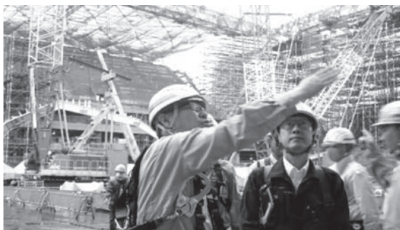
現場のパトロール状況
