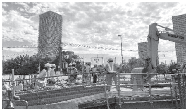
(マンション新築工事 2)
