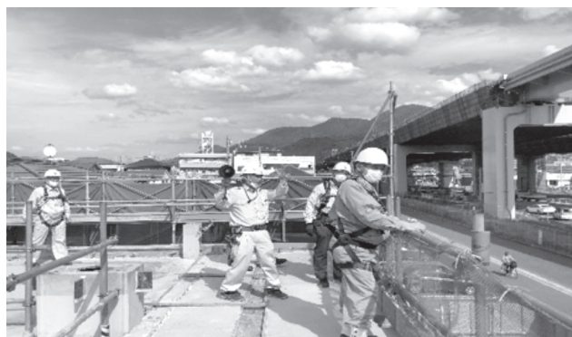
(庁舎新築工事 1)
