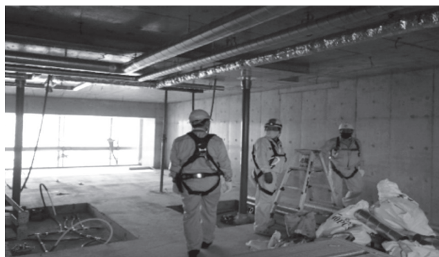
(マンション新築工事 1)
