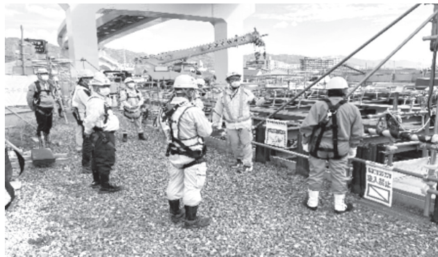
(JR線路下アンダーボックス工事)
