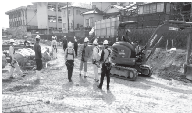
(小学校グラウンド造成工事)
