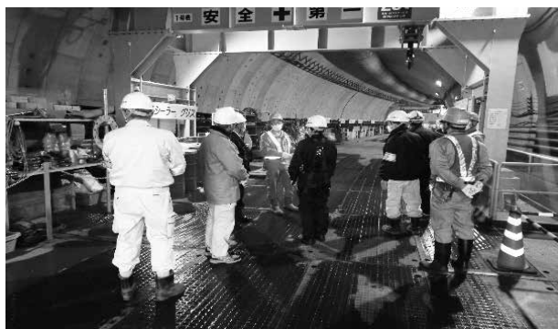
高速道路シールドトンネル工事
