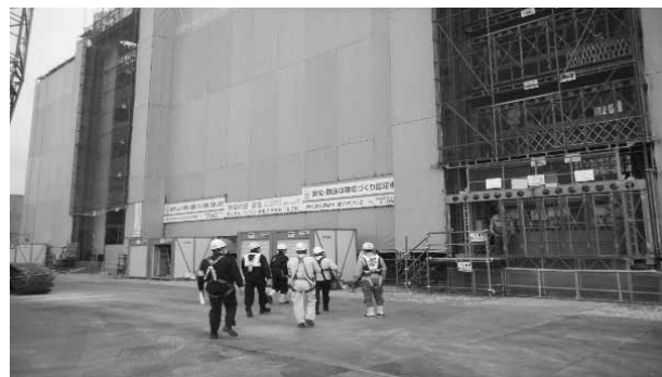
マンション新築工事
