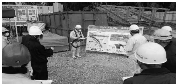
道路橋下部工事
