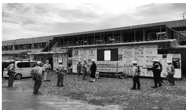
マンション新築工事
