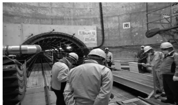
下水道シールド工事
