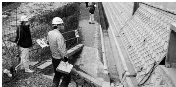
主要地方道 吉田豊栄線 道路災害防除工事(その2)
