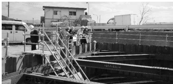
大竹港橋梁補修工事
