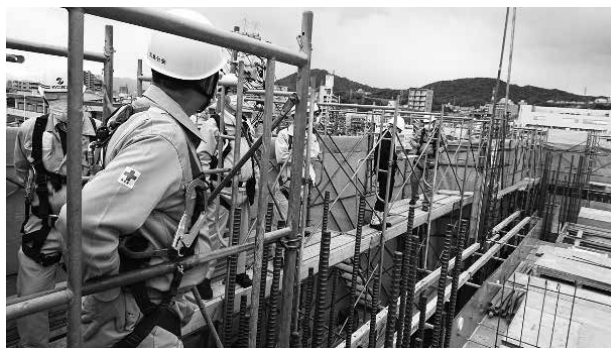
マンション新築工事
