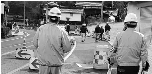
主要地方道 吉田豊栄線 交通安全施設等整備工事
