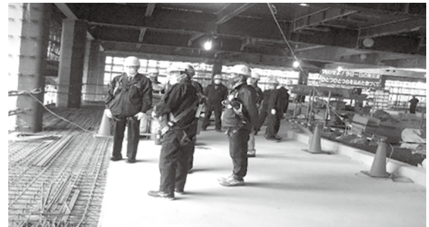
(現場のパトロール状況)
