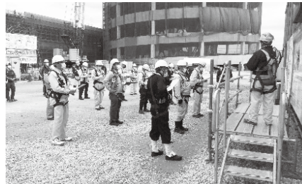
西区 物流施設新築工事
