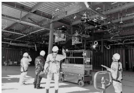
尾道地区 工場新築工事
