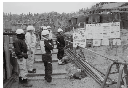
因島地区 墓地災害復旧工事
