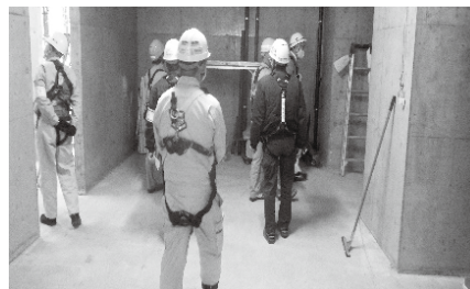
中区 マンション新築工事
