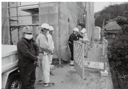
因島地区 木造住宅新築工事
