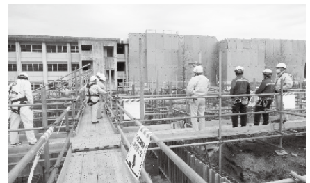
東広島地区 小・中学校増築・改修工事
