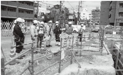
東区 マンション新築工事
