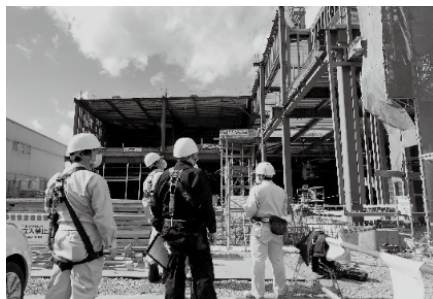
尾道地区 工場新築工事
