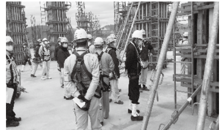
西区 物流施設新築工事
