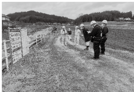
世羅地区 河道浚渫工事
