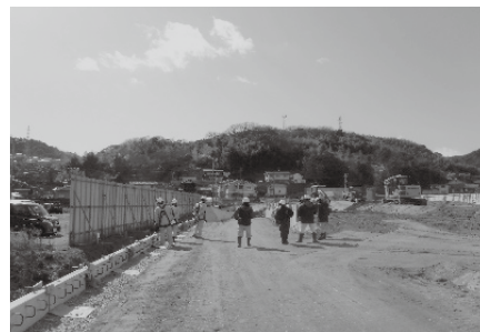
尾道地区 道路改良工事
