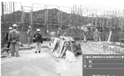
南区・安芸地区 県営住宅新築工事
