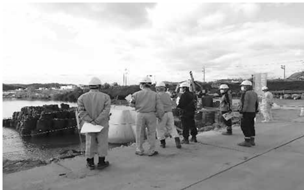
河川激甚災害対策特別緊急工事
