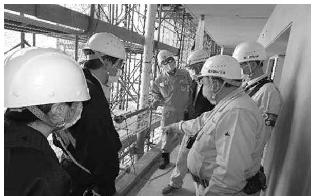
マンション新築工事
