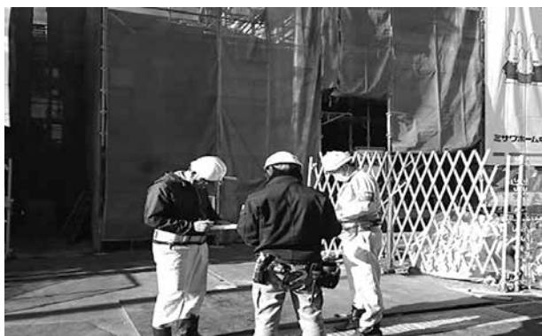
木造低層住宅新築工事
