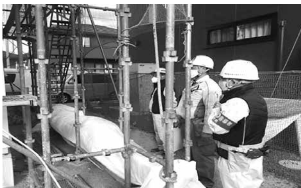
木造低層住宅新築工事
