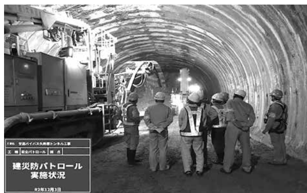
トンネル工事
