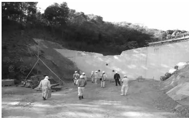
災害関連緊急砂防工事
