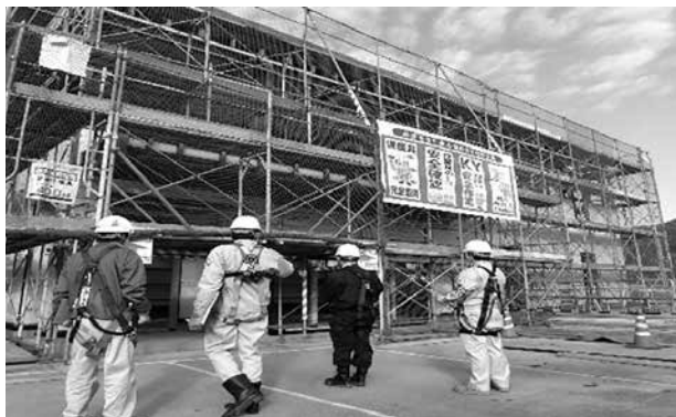
大学施設新築その他改修工事
