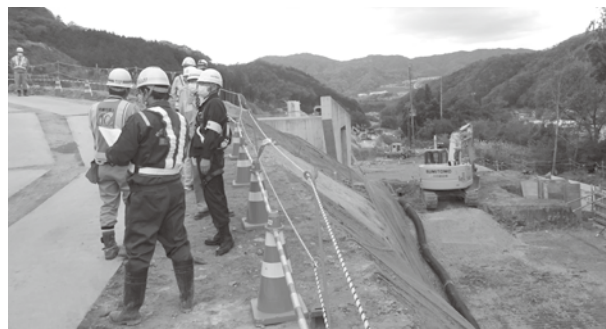
（現場のパトロール状況）
