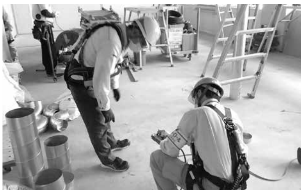
(大学研究棟改修等工事)
