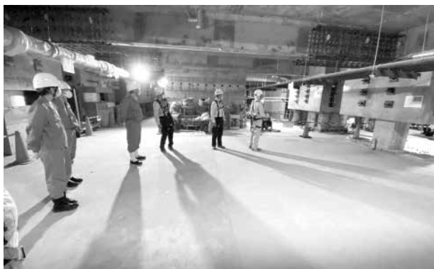
(合同庁舎耐震工事)
