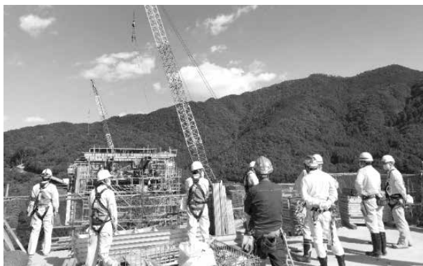
(バイパスPC上部工工事)
