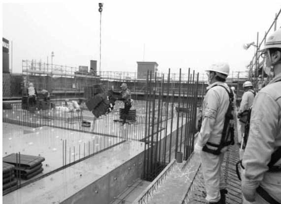
共同住宅新築工事(2)
