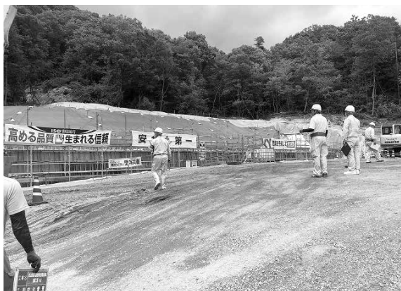
公共土木工事
