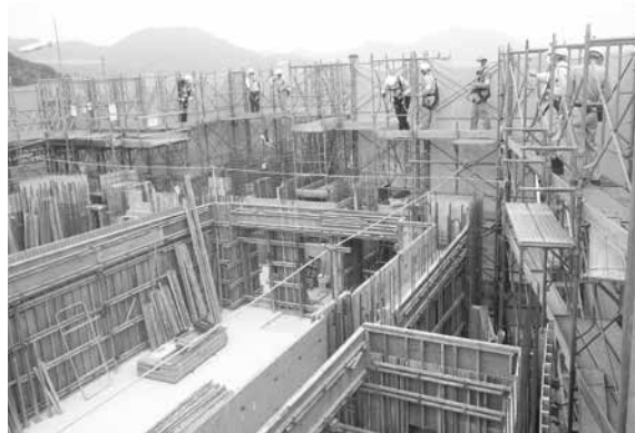
共同住宅新築工事(3)
