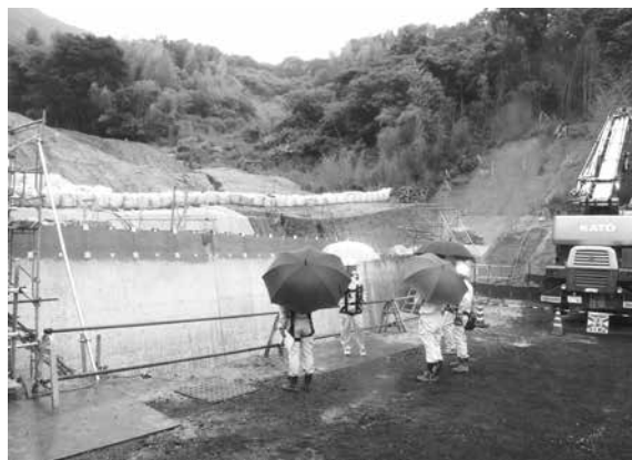
公共土木工事
