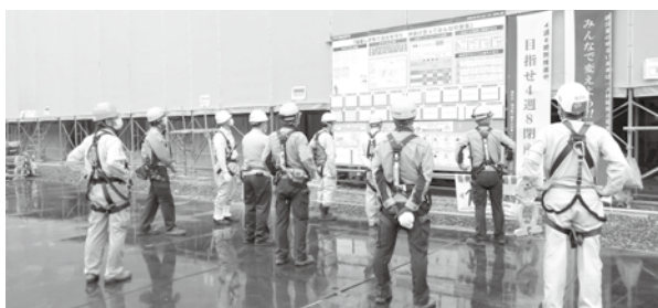
共同住宅新築工事(1)
