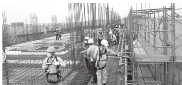
共同住宅新築工事(1)
