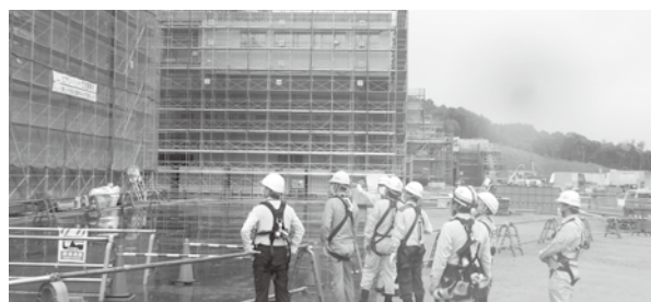
公共施設整備工事
