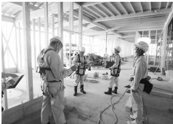
民間建築工事
