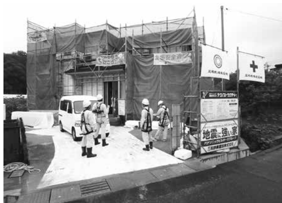
木造住宅新築工事
