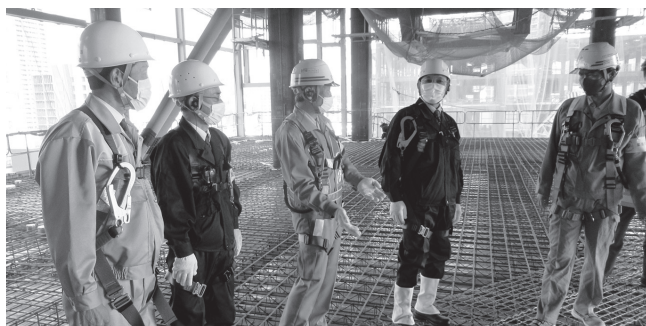
（現場のパトロール状況）
